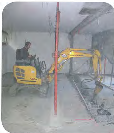
DES PELLES MÉCANIQUES DANS LA HEP-VS
